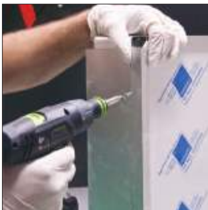
Fissaggio cornice angolare
