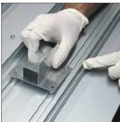
Fissaggio fazzoletti
